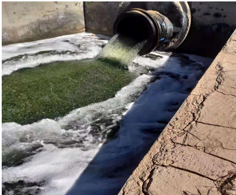
图 4.1-2 滨化集团工业水运营中心污水总排口
